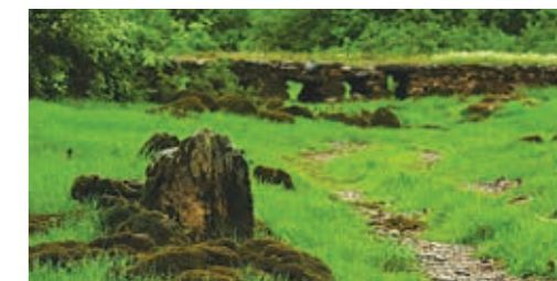
Puente de piedra atravesando el Suvaja
